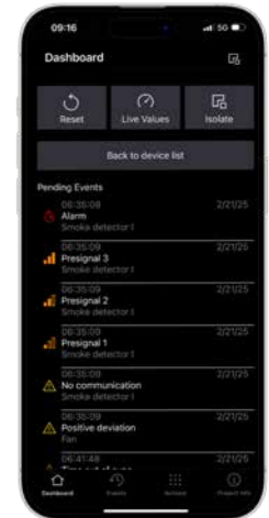
Painel de controlo
