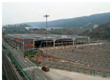
系统产品：SecuriSmoke ASD 535 完工年份：2022年 项目类型：地铁车站 / 车辆段 项目名称：重庆轨交4号线 . 二期
