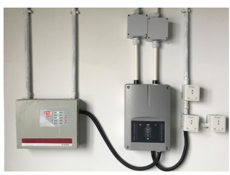
系统产品：SecuriSmoke ASD 535 完工年份：2019年 项目类型：物流仓库 项目名称：北京通州口岸仓储项目二、三期
